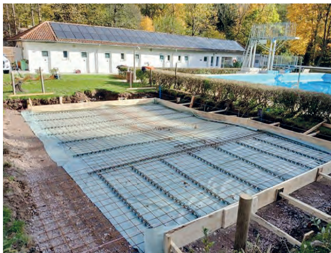
Neuerrichtung Bodenplatte Kinderbecken Freibad Ilfeld
